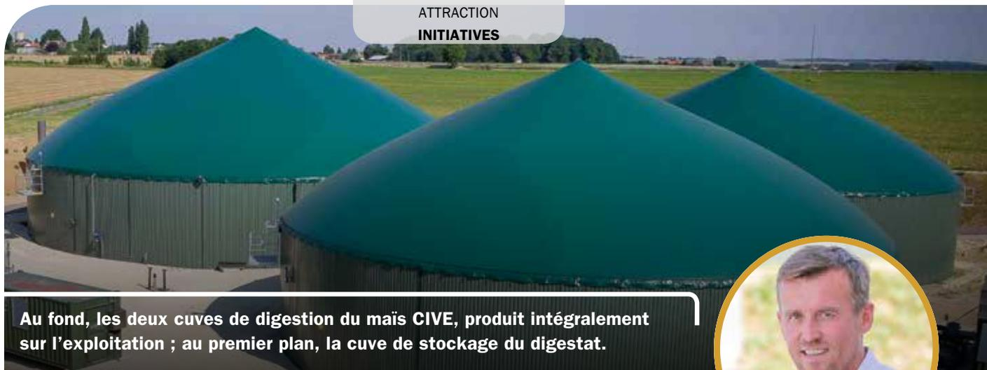
**Au fond, les deux cuves de digestion du maïs CIVE, produit intégralement sur l'exploitation ; au premier plan, la cuve de stockage du digestat.**
